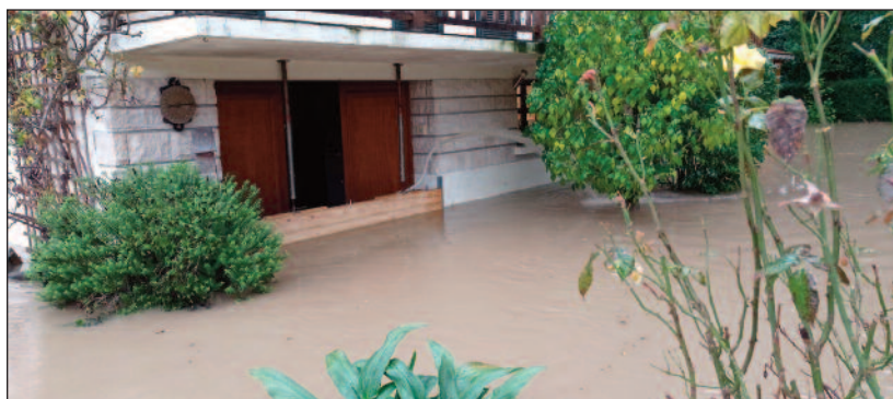
Pose de batardeaux
