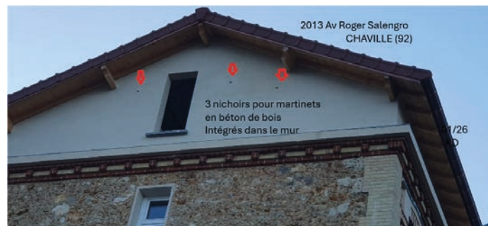
Trois nichoirs artificiels en béton de bois intégrés dans le mur rénové (flèches rouges) - janvier 2026 © Katherine Dubourg
