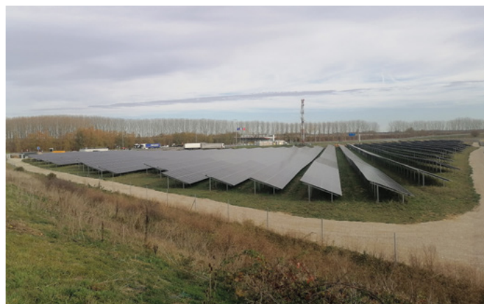
La centrale photovoltaïque au sol à Saint-Germain-en-Laxis, dernière en date installée en Seine-et-Marne, sur 6,6 ha. Elle est composée de 8600 panneaux solaires et dotée d'une puissance de 5,3 mégawatts-crête (MWc) © Jane Buisson
