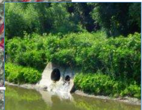
Réseau d'eaux pluviales et sources
