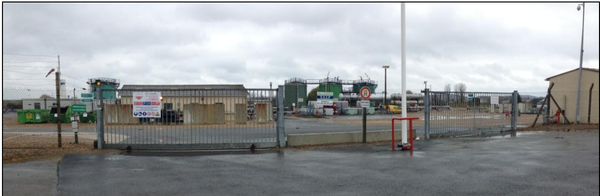
Figure 12 : Entrée de la plate-forme VLG Centre
