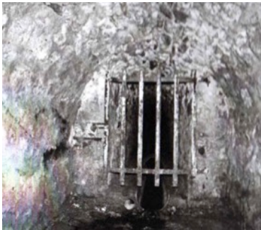
Débouché de l'aqueduc
